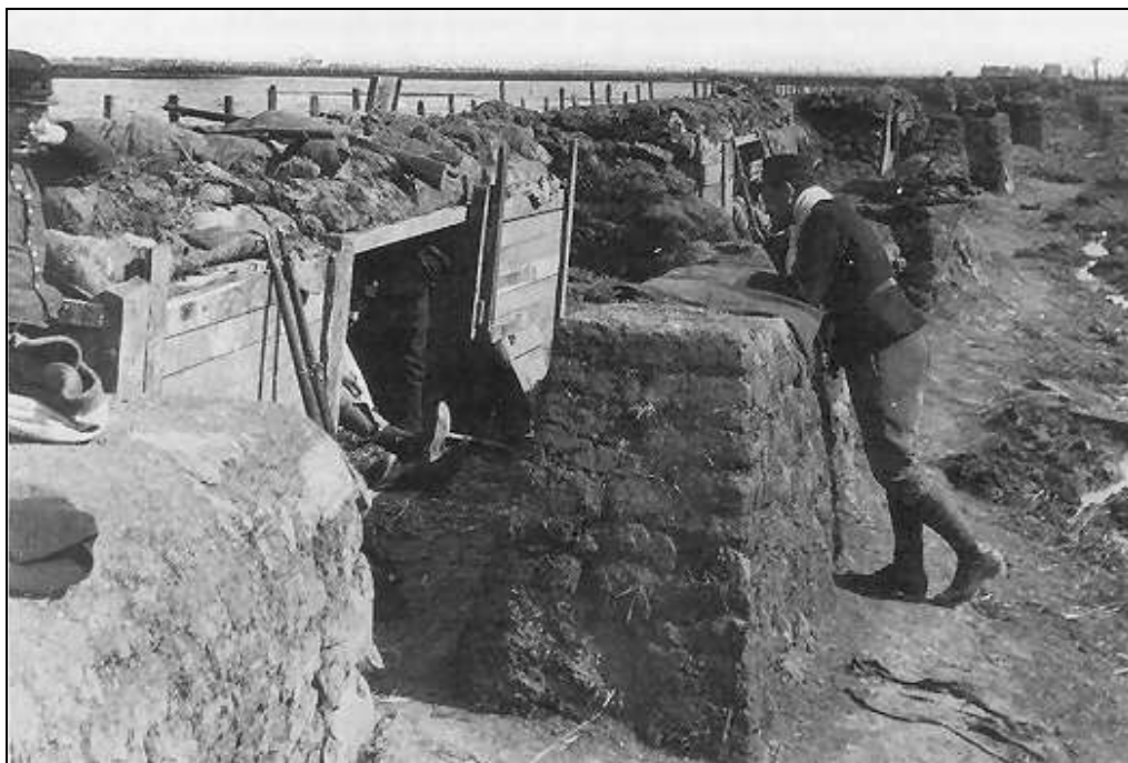
De versterkingen van het Belgisch leger aan de spoorweg Nieuwpoort - Diksmuide.
