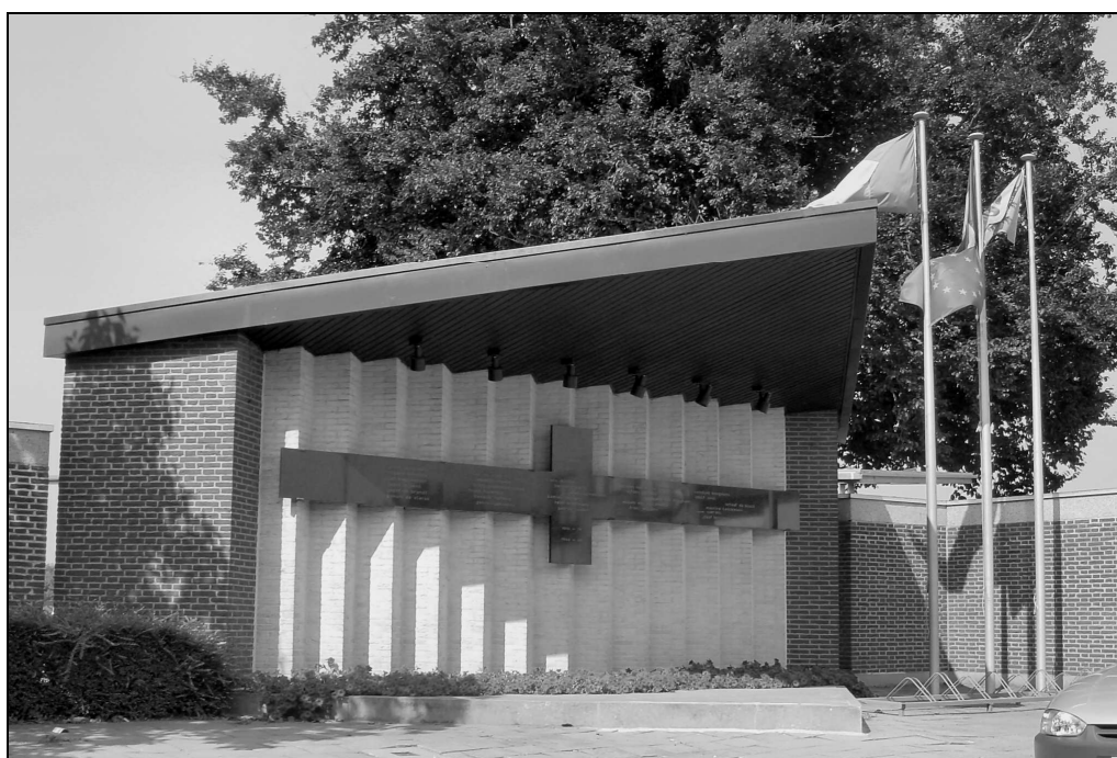
Gemeentelijk monument der gesneuvelden, gebouwd in 1972 tegen de kerkhofmuur langs de Ringlaan.
