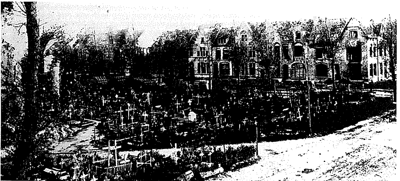
Gevelpartij van het woningblok in de Willem De Rooiaan, ten zuiden van de O.-L.-Vrouwekerk, 1916. (Privé-verzameling)
