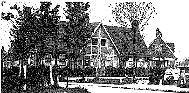
Semi-permanente woning van het Acke-type in de Ezelbrugwijk te Menen. (Archief Verwilghen, K.U. Leuven)
