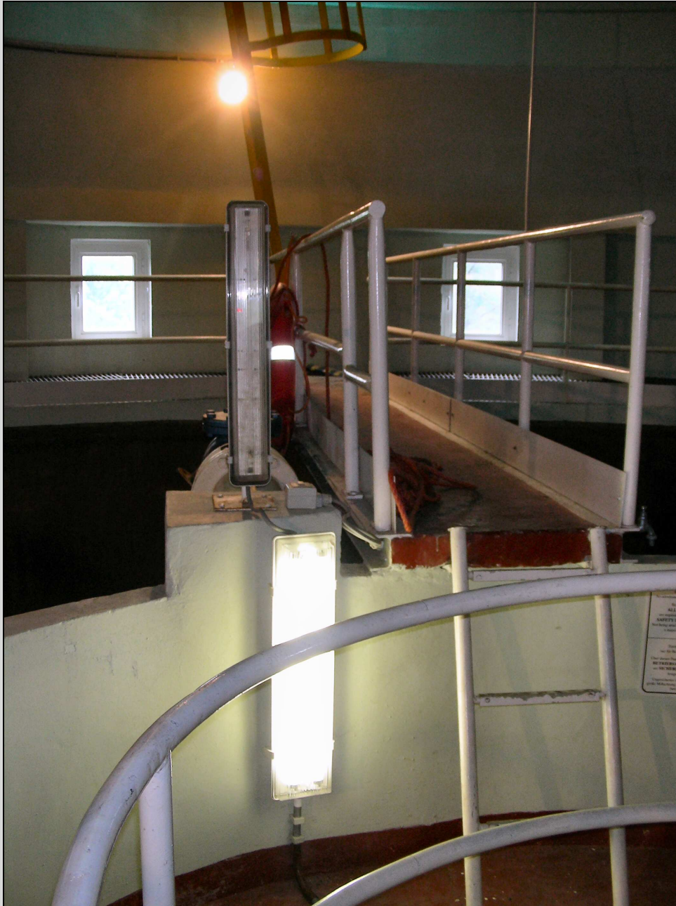
Foto boven in de watertoren van Droeshout. Van voor naar achter: de borstwering van de trap en platform ter hoogte van de waterkuip, de borstwering van de kuip, de loopbrug boven het water naar de loopbrug rondom de waterkuip, de ladder naar het toegangsluik tot het dak, de buitenwand van de toren, en de aanzet van het koepeldak van de toren.
