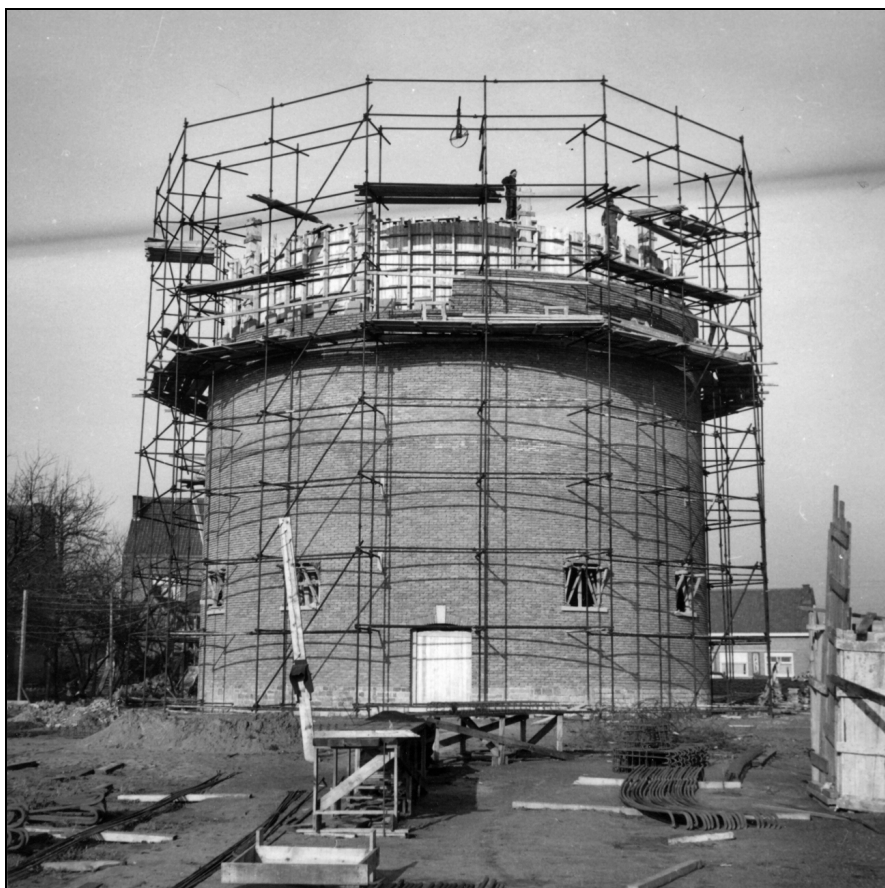
De watertoren van Droeshout in de steigers, 1955.
