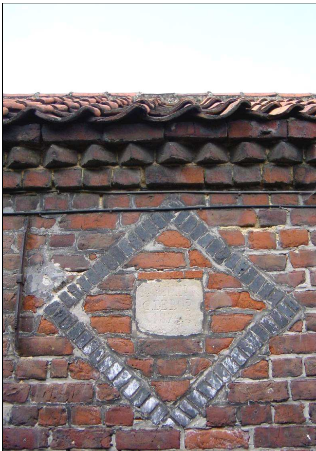
Baksteenmuur met fraaie bovenafwerkingen en dak met gebakken Boomse golfpannen, in het verbindingsbaantje tussen de Steenweg en de Verlorenkostbaan (Mazenzele). In de muur, in een omranding in ruitvorm van zwart siermetselwerk, een natuurstenen blok met daarin de naam gebeiteld van vroegere eigenaars (P. Heninck en C. De Rop) met het jaartal 1872..
