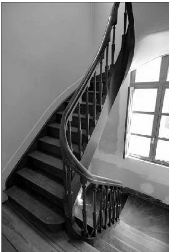
Originele trap van de pastorie (1850). Eerste verdieping.
