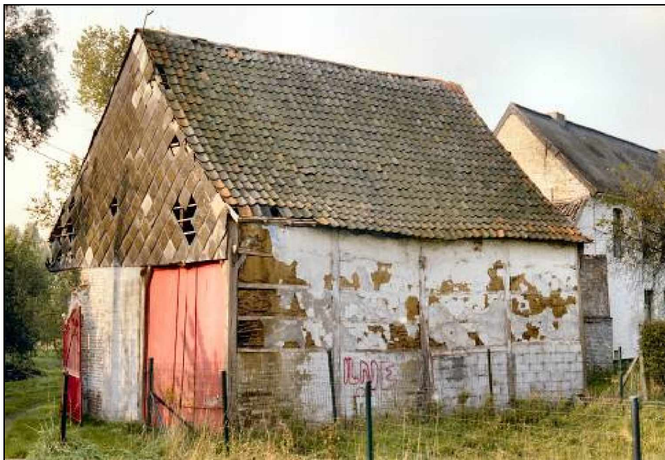
Houten vakwerkschuur (met leemvulling) van de Oude Pastorie van Opwijk, foto 1991.
