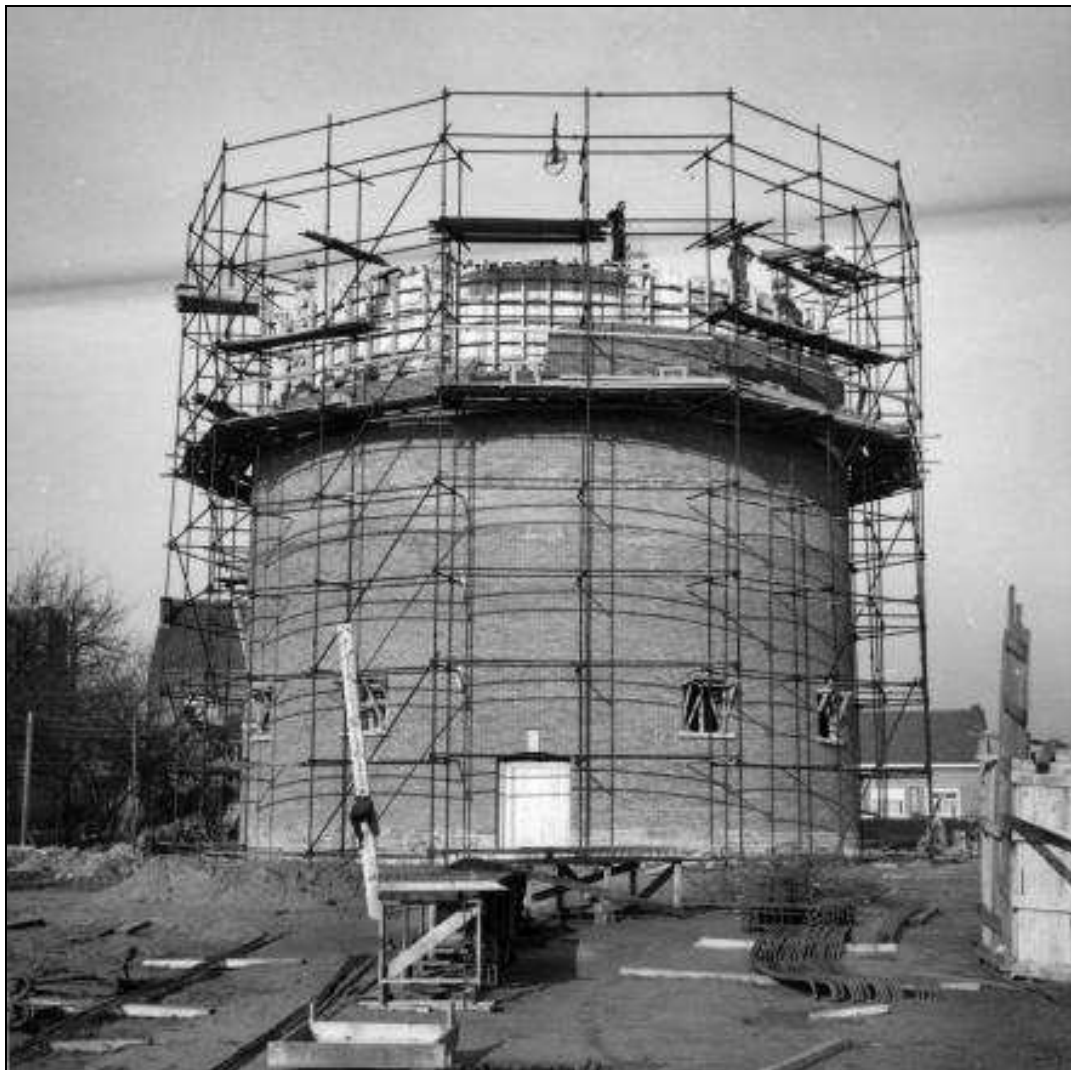
De watertoren van Droeshout in de steigers, 1955.
